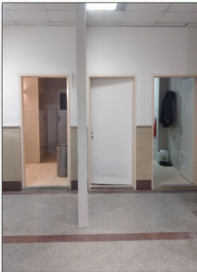
● اجرای دیوار کناف بین آبدارخانه و سرویس بهداشتی
