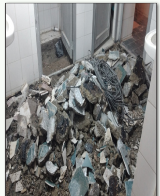
● تخریب کف‌های قدیمی سرویس بهداشتی برای نوسازی قیرگونی کف
