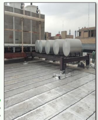
● سقف موتورخانه مرکزی
