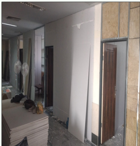
● اجرای دیوارهای درای وال عایق حرارتی و صوتی پشم سنگ
