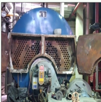
● محل قرارگیری لوله‌های آتشخوار دیگ بخار
