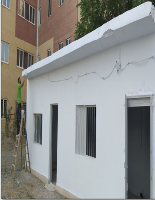
● اتاق‌های کارگاهی جنب ساختمان ایثار
