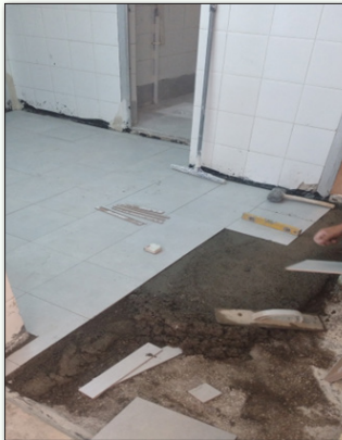
● اجرای سرامیک کف
