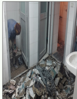
● تخریب کف‌های قدیمی سرویس بهداشتی برای نوسازی قیرگونی کف
