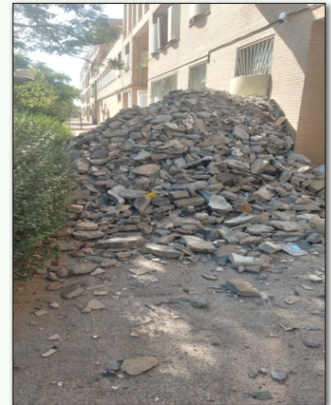
● جمع‌آوری نخاله‌های حاصل از تخریب
