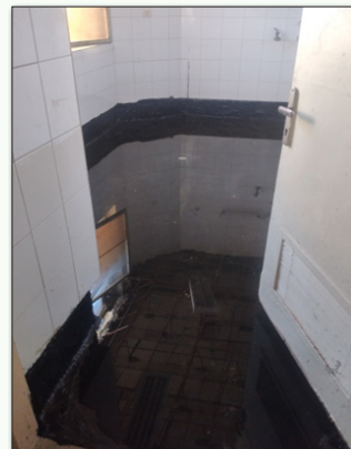
● تست نشتی کف آشپزخانه با آب
