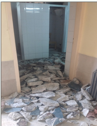
● تخریب کف سرویس بهداشتی موجود برای اجرای قیرگونی و کف‌سازی جدید
