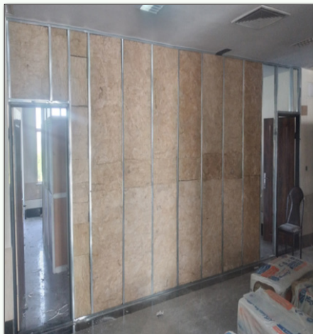
● اجرای دیوارهای درای وال عایق حرارتی و صوتی پشم سنگ
