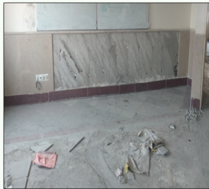
● نصب سنگ پلاک
