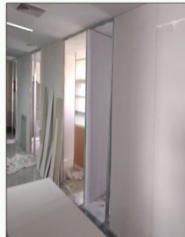
● اجرای گچ برگ رویه
