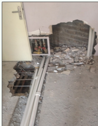
● تعویض لوله‌های تأسیساتی
