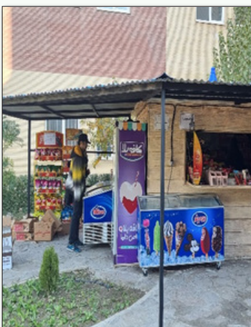
● اجرای سقف شیروانی بوفه
