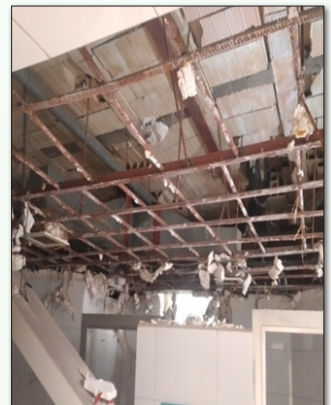
● آماده‌سازی برای اجرای سقف کاذب
