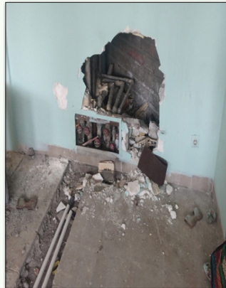
● تعویض لوله‌های فرسوده رایزر
