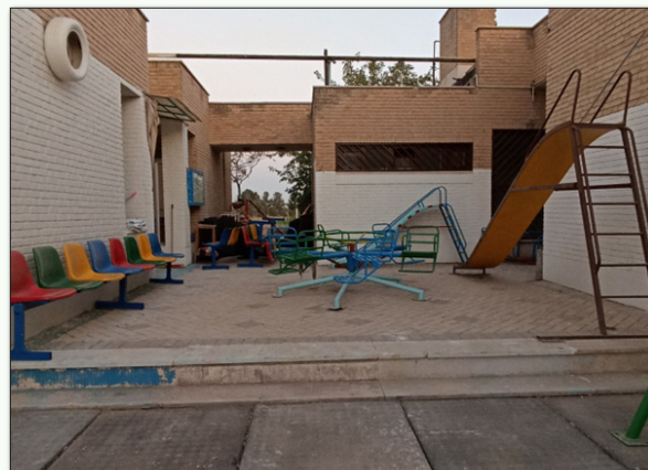
● اجرای سایبان مهد کودک - قبل از اجرا
