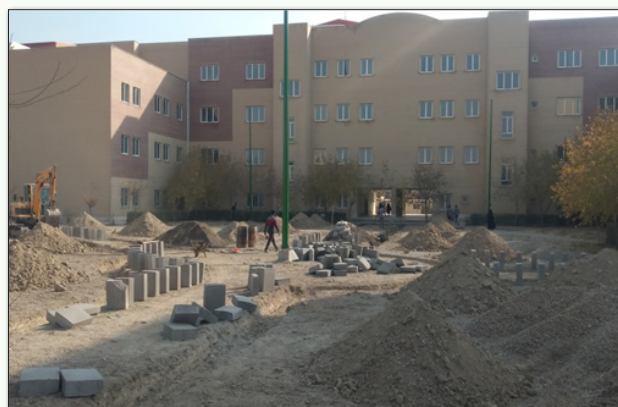
محوطه سازی، شروع عملیات اجرایی زمستان ۱۴۰۱
