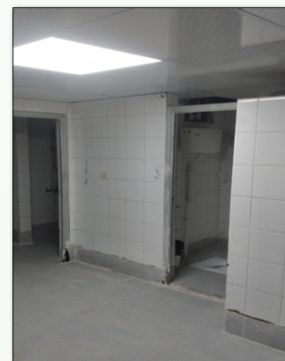
● اجرای سرامیک کف، سقف کاذب و روشنایی
