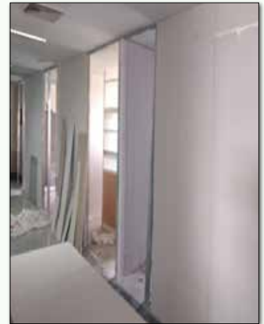
● اجرای گچ برگ رویه
