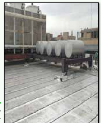
● سقف موتورخانه مرکزی
