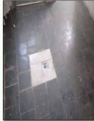
● بازسازی لوله‌های فاضلاب و اصلاحات کف شور و رفع نشتی و آب‌بندی مجدد
