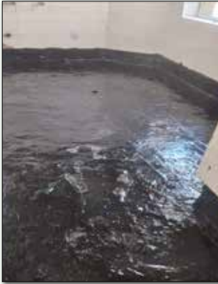
● قیرگونی کف آشپزخانه و سرویس‌های بهداشتی
