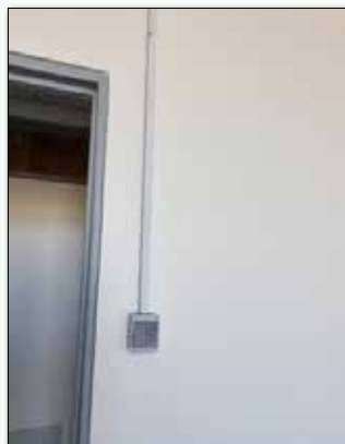
● داکت کشی کابل های برقی
