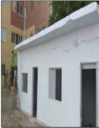
● اتاق‌های کارگاهی جنب ساختمان ایثار
