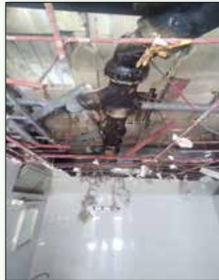
● تخریب سقف کاذب قدیمی سرویس‌های بهداشتی برای دسترسی به لوله‌های تأسیساتی و اجرای سقف کاذب متحرک
