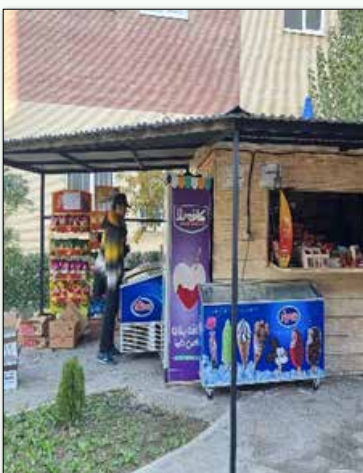
● اجرای سقف شیروانی بوفه
