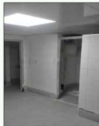
● اجرای سرامیک کف، سقف کاذب و روشنایی
