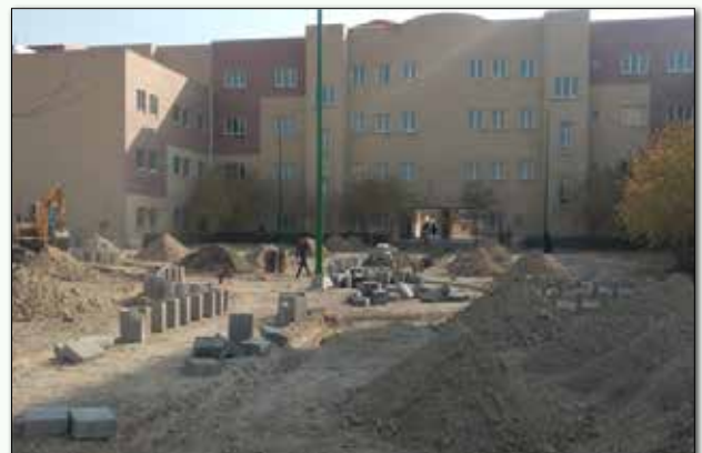
محوطه سازی، شروع عملیات اجرایی زمستان ۱۴۰۱
