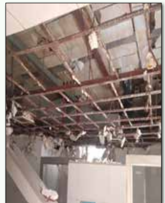
● آماده‌سازی برای اجرای سقف کاذب
