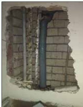
● تخریب برای دسترسی به رایزر تأسیساتی و تعویض رایزرهای عمودی ساختمان
