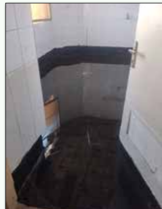
● تست نشتی کف آشپزخانه با آب
