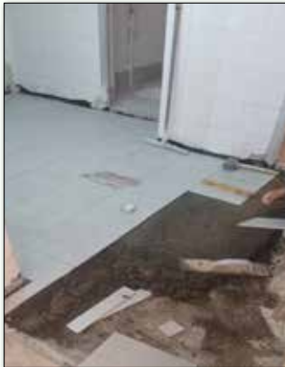
● اجرای سرامیک کف
