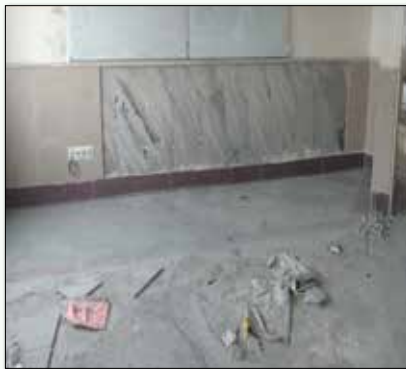
● نصب سنگ پلاک
