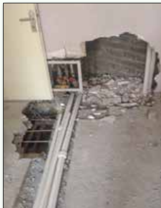
● تعویض لوله‌های تأسیساتی
