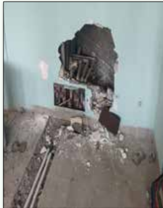
● تعویض لوله‌های فرسوده رایزر
