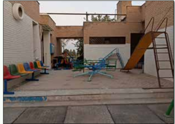
● اجرای سایبان مهد کودک - قبل از اجرا
